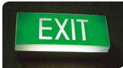
Se establece la **obligación de instalar equipos que dispongan de un sistema automático de control del funcionamiento y de la autonomía**, de tal manera que el titular responsable de la instalación pueda conocer en cualquier momento si dichos equipos están en situación correcta o, proceder a su inmediata sustitución si ello no fuera así.
